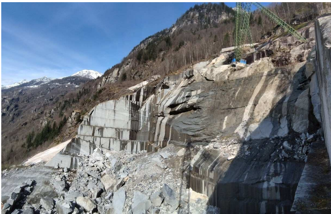
FOTO N. 1 – L'ACCUMULO DI FRANA ALLA BASE DEL FRONTE NORD PRIMA DELL'INTERVENTO DI CONSOLIDAMENTO CORTICALE, PULIZIA DEL GRADONE DI Q. 1082 M E SISTEMAZIONE DEL DETRITO PIÙ FINE.
