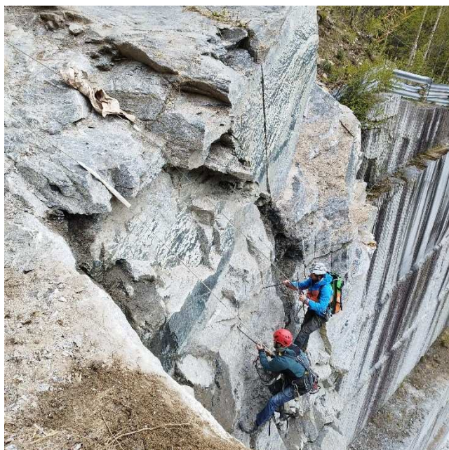
FOTO N. 2 / 3 - INTERVENTI DI DISGAGGIO MANUALE PREVENTIVI NELL'ANGOLO NE DEL FRONTE E POSA DEL RAFFORZAMENTO CORTICALE
