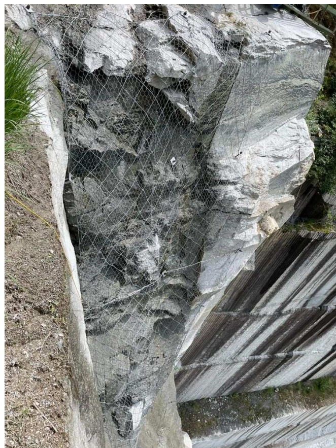
FOTO N. 2 / 3 - INTERVENTI DI DISGAGGIO MANUALE PREVENTIVI NELL'ANGOLO NE DEL FRONTE E POSA DEL RAFFORZAMENTO CORTICALE
