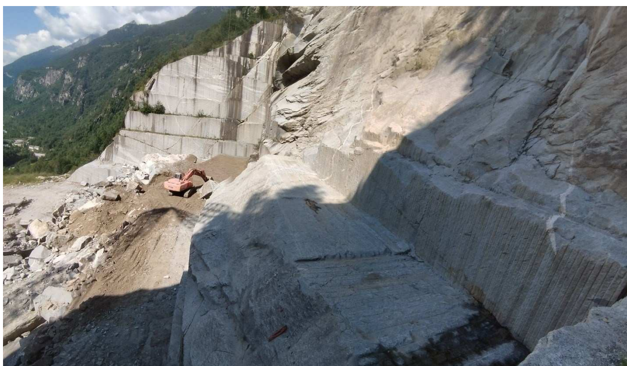
FOTO N. 8/9 – RIPRESA PANORAMICA E RAVVICINATA DELLA COMPLETA SISTEMAZIONE DEL GRADONE AL PIEDE DEL FRONTE E DELLA PULIZIA DEL GRADONE IN ROCCIA TRACCIATO A Q. 1082 M.
